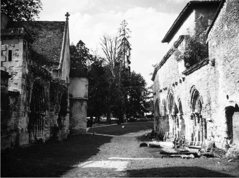
Les ruines du prieuré de Cayac, en banlieue sud de Bordeaux.
